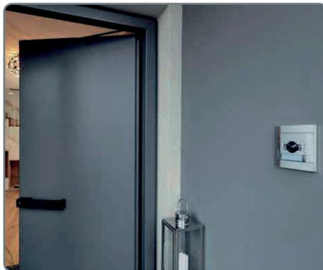
Im Bereich der Haustürsprechanlage ist eine Kamera angebracht. Sie sorgt dafür, dass man sowohl auf einem Bildschirm im Haus als auch via App auf dem Smartphone sehen kann, wer sich vor der Haustür befindet
