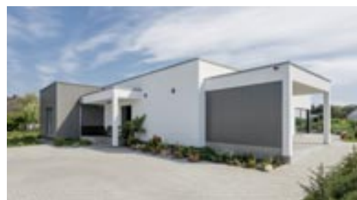
Der Baukörper schirmt den großen Garten ab und zeigt sich zur Straße hin zugeknöpft.
