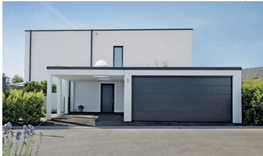
Der Hauseingang ist wettergeschützt und ebenerdig erreichbar.
